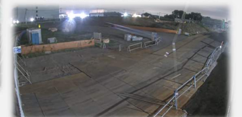
ひとけの少ない現場での敷き鉄板盗難の防犯対策
