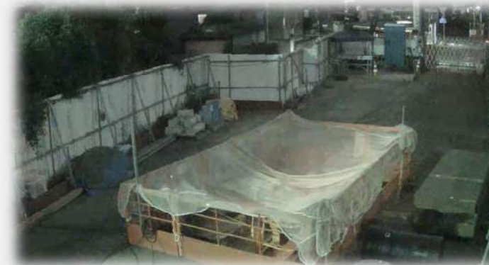
周りに住宅地が多い現場での悪戯の監視
