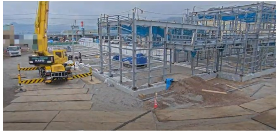
外壁鉄骨の組み立て施工中（2日目）（動画再生時間26秒間内）
