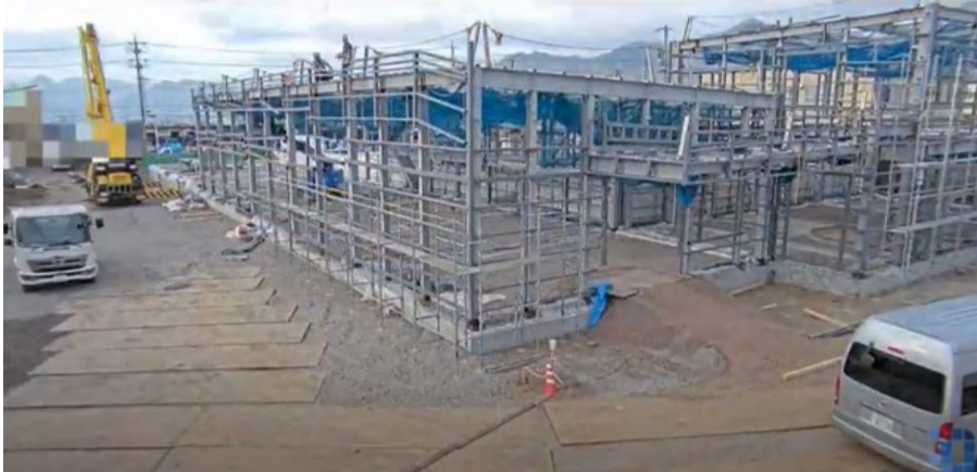
外壁鉄骨の組み立て施工中（3日目）（動画再生時間26秒間内）
