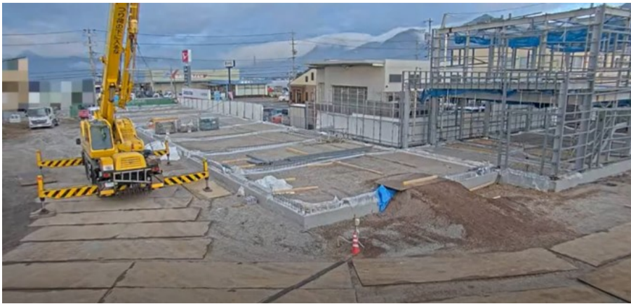
外壁鉄骨の組み立て着手前（1日目）（動画再生時間26秒間内）
