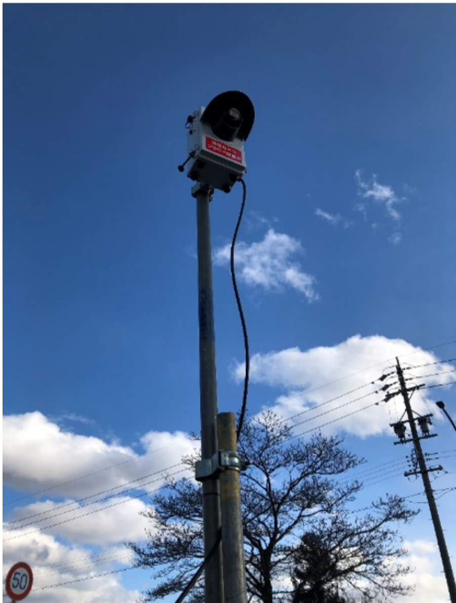
単管設置事例
