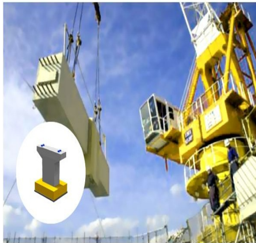
現場打ちの効率化プレキャストの進化
