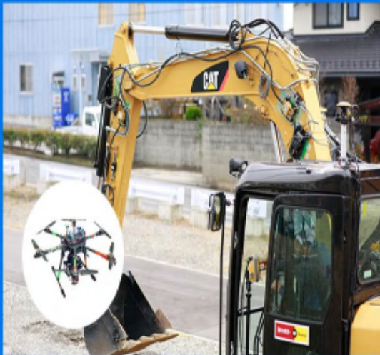
UAVによる3次元測量、検査ICT建機による自動制御施工
