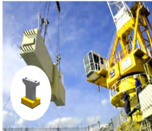
現場打ちの効率化プレキャストの進化
