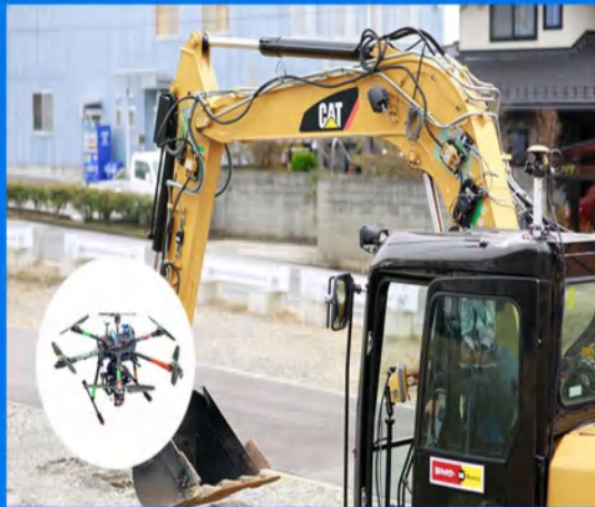
UAVによる3次元測量、検査ICT建機による自動制御施工
